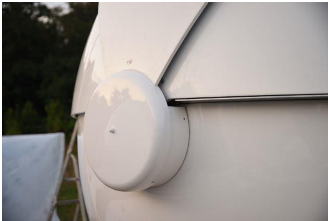
Rys. 61 – Zamontowana osłona zespołu napędowego – lewa strona, widok z przodu kopuły.
