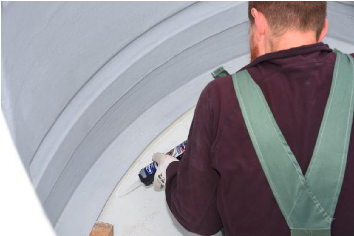
Rys. 15 – nakładanie uszczelnień pod podstawą kopuły
