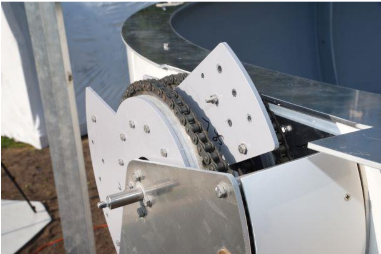
Rys. 38 – śruby mocujące podkładki w uchwytach klapy i pozycja uchwytów przed instalacją klapy
