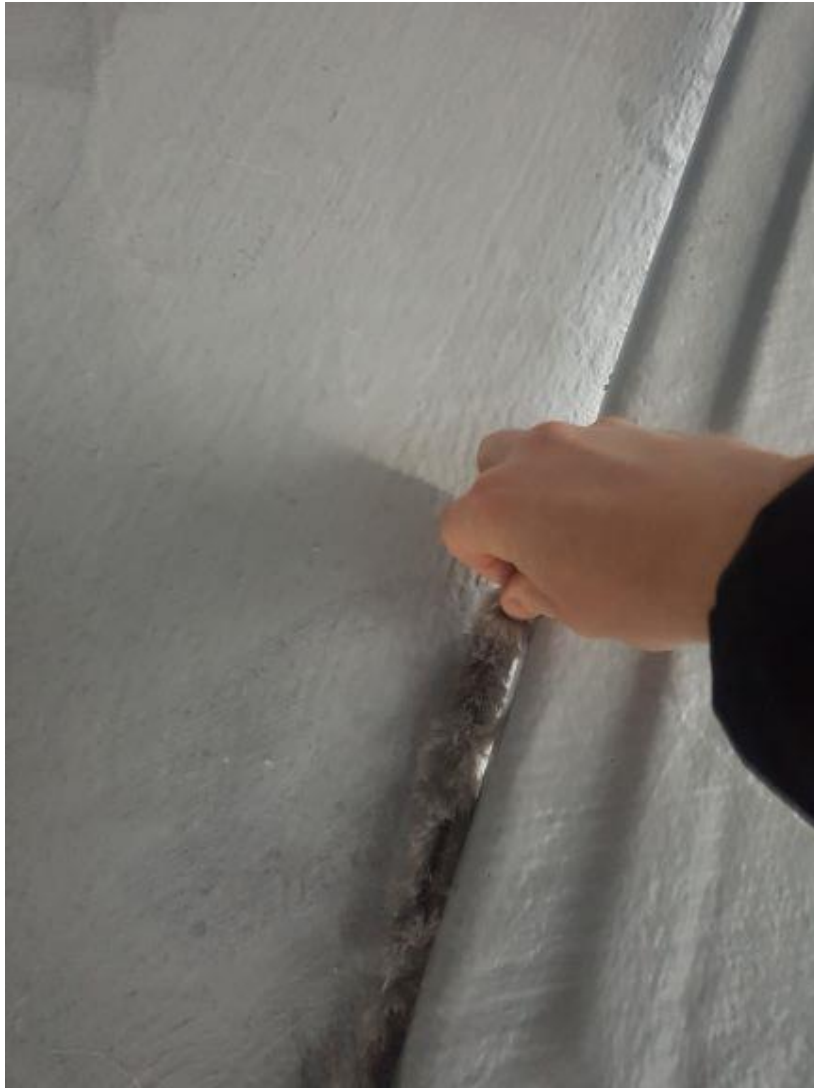
Rys. 70 –Montaż uszczelki na pokrywie nr 3
