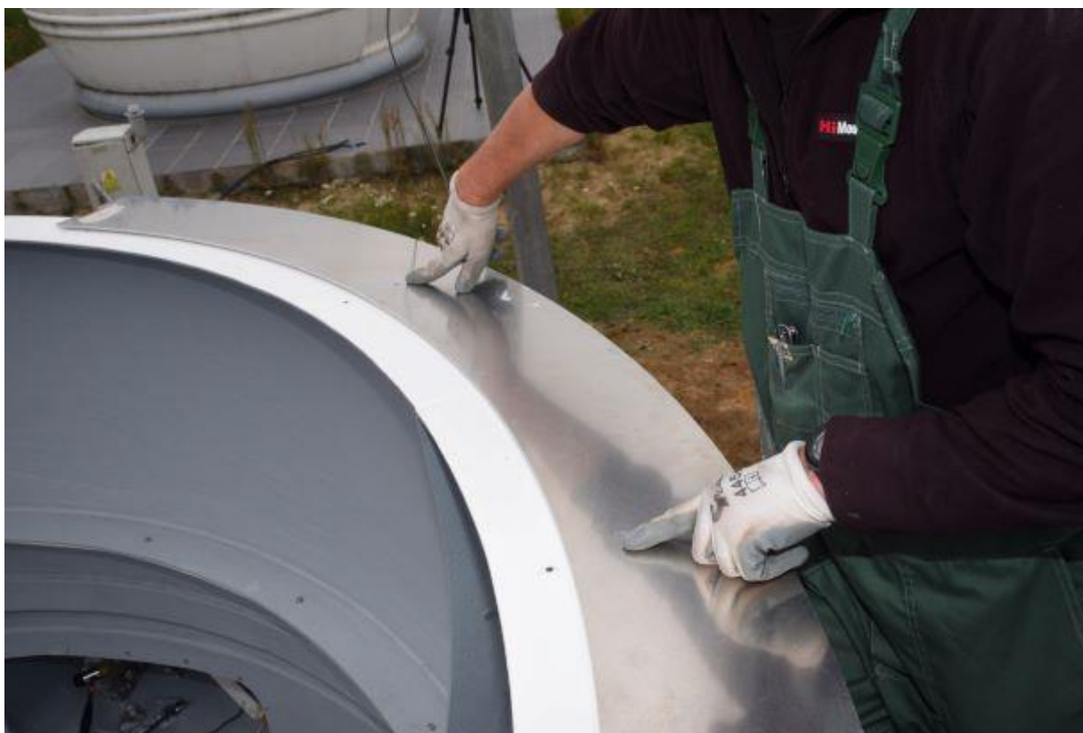
Rys. 27 – Otwory mocujące pierścień do podstawy kopuły
