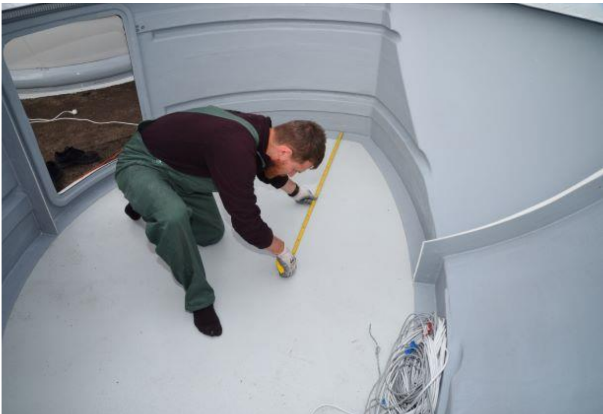
Rys. 9 – pozycjonowanie podstaw kopuły c.d.
