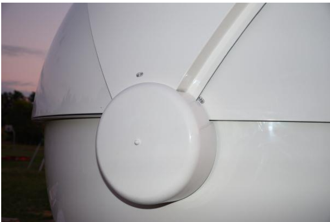
Rys. 62 – Zamontowana osłona zespołu napędowego – prawa strona, widok z tyłu kopuły.
