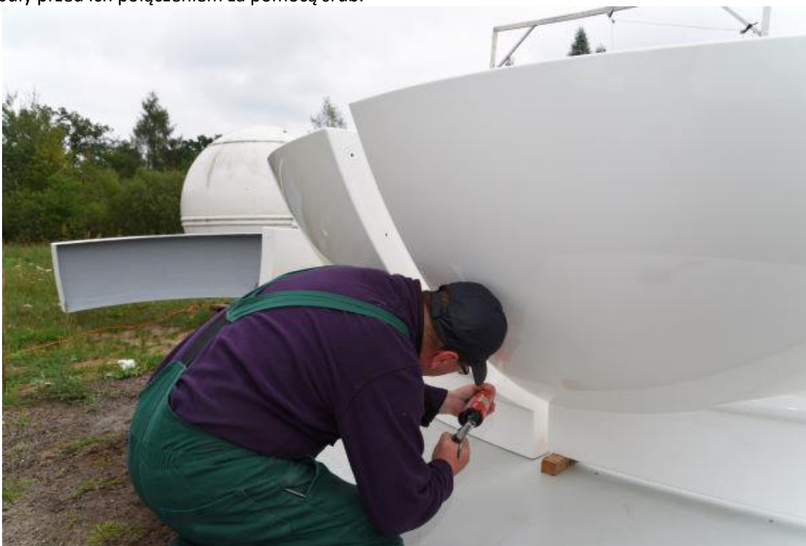
Rys. 16 – nakładanie uszczelnień na płaszczyznach łączących podstawę
