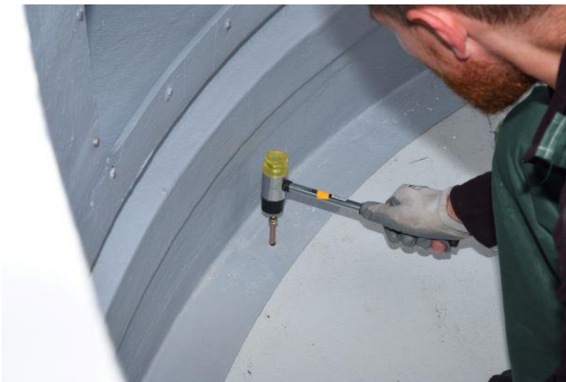
Rys. 17 – mocowanie podstawy za pomocą kotw
