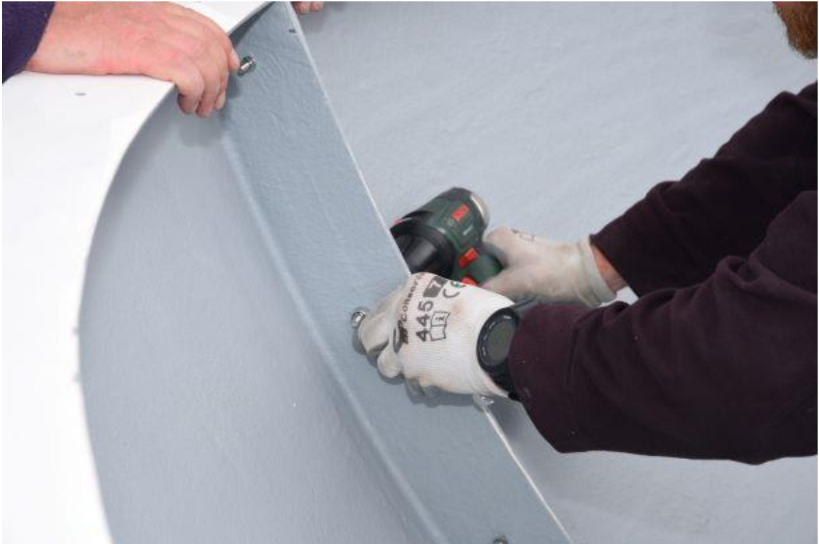
Rys. 18 – skręcanie podstaw kopuły
