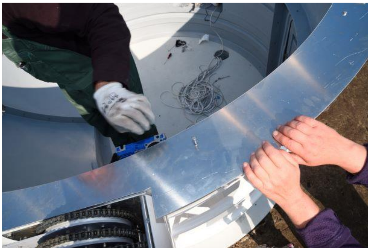
Rys. 30 – Montaż bocznych elementów pierścienia usztywniającego
