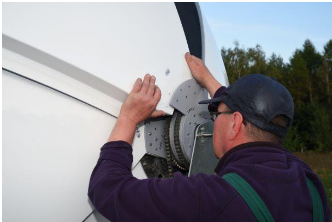
Rys. 53 - pokrywa nr 3 montaż w uchwytach – widok lewej strony
