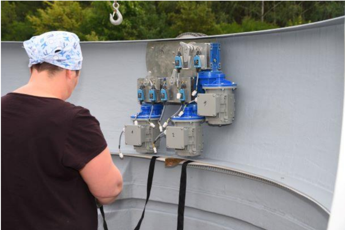
Rys. 6 – założenie pasów transportowych pod górną część podstawy kopuły
