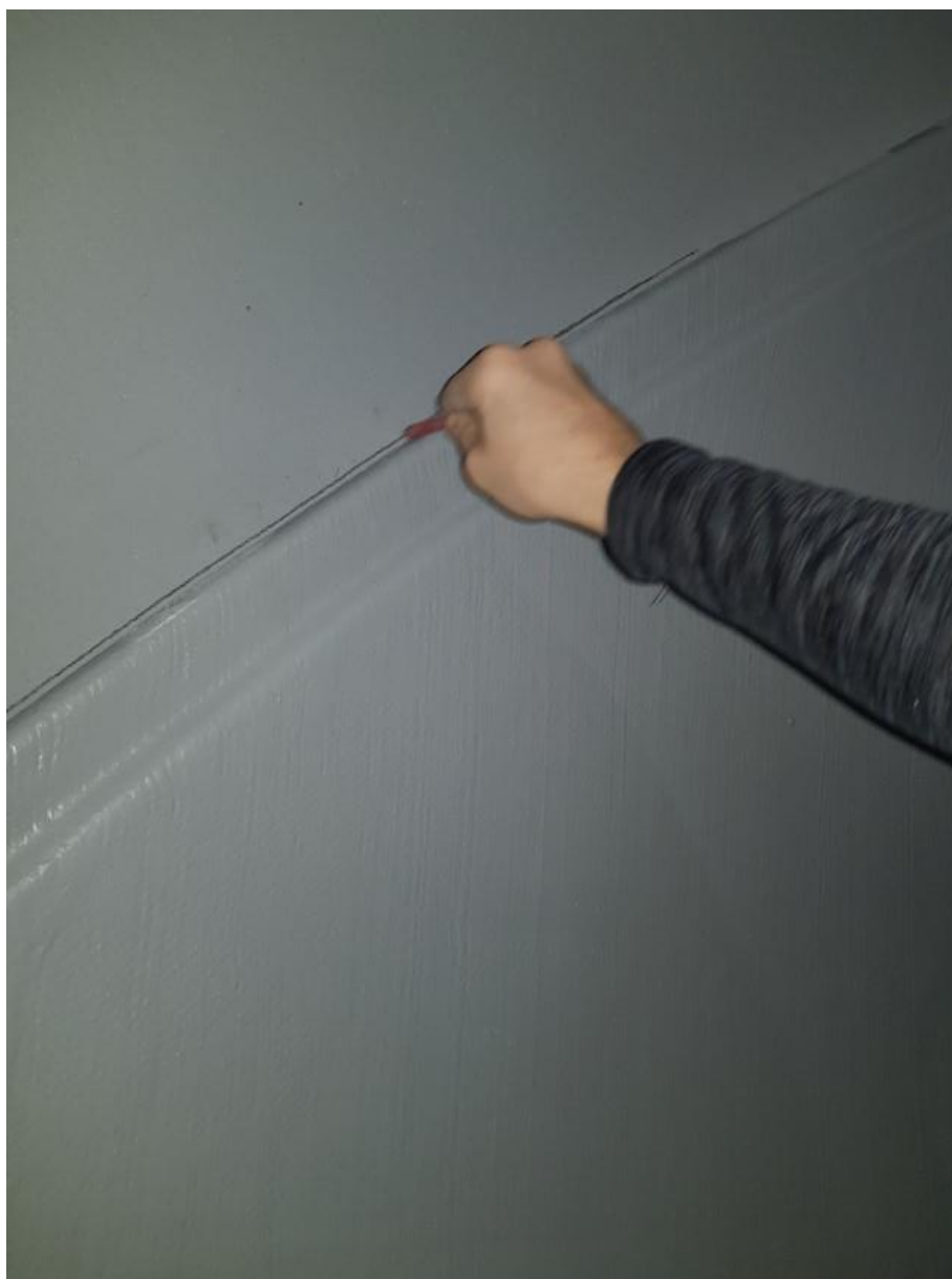
Rys. 69 – Wyznaczenie linii montażu uszczelki na pokrywie nr 3
