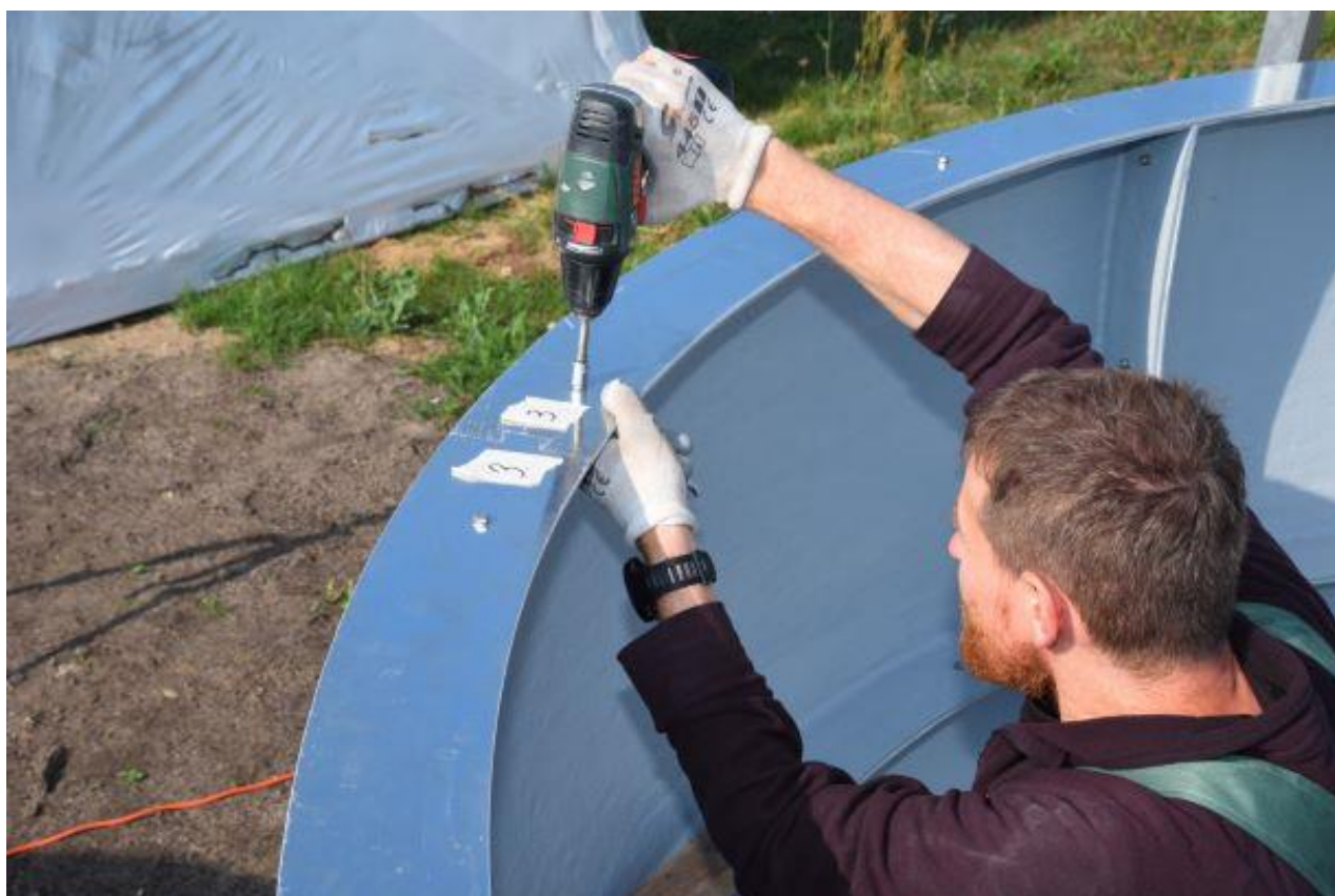
Rys. 31 – skręcanie pierścienia usztywniającego z podstawą kopuły
