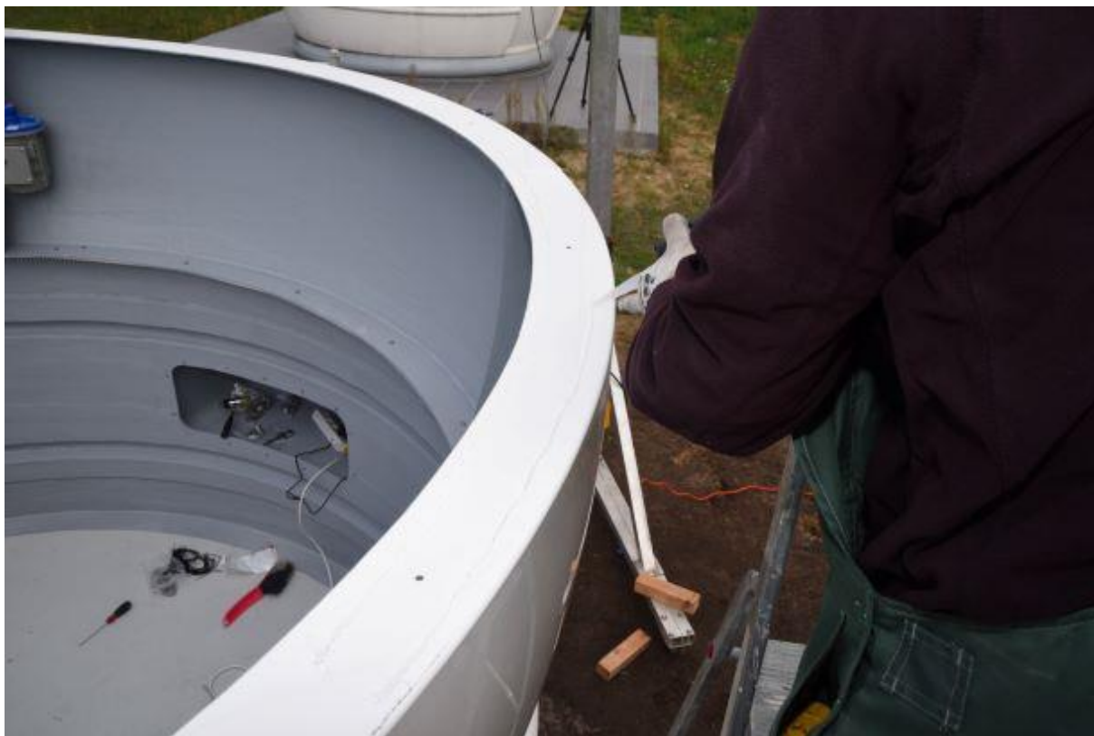
Rys. 28 – Uszczelnianie połączenia pierścienia z podstawą kopuły
