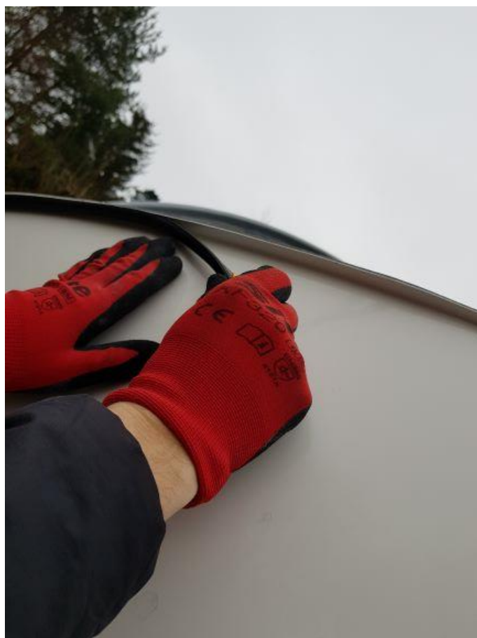
Rys. 68 – Sposób przyklejania uszczelki na pokrywie nr 2
