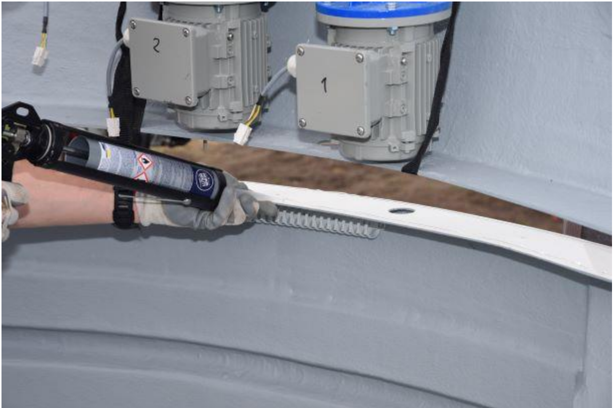
Rys. 20 – uszczelnianie miejsc łączenia elementów podstawy kopuły
