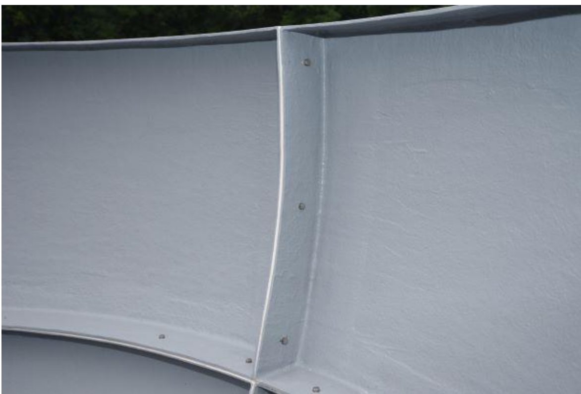
Rys. 25 – Połączenia śrubowe górnych elementów podstawy kopuły
