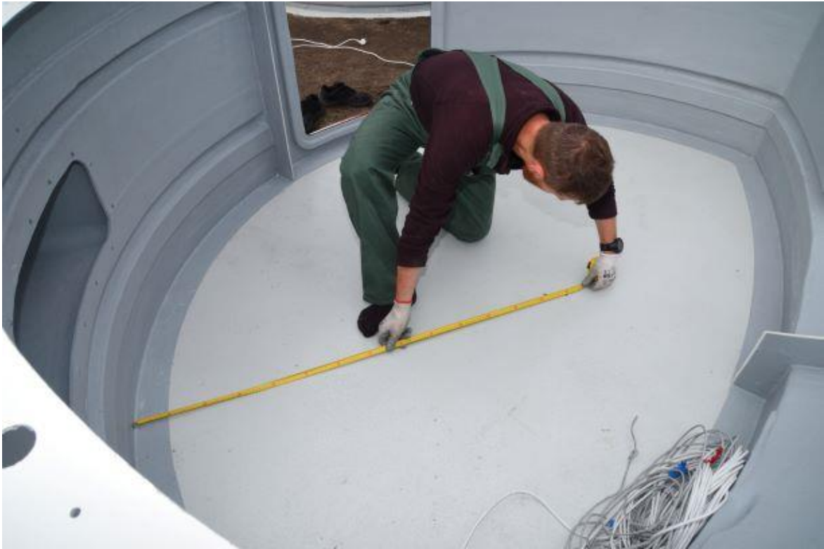
Rys. 8 – pozycjonowanie podstaw kopuły
