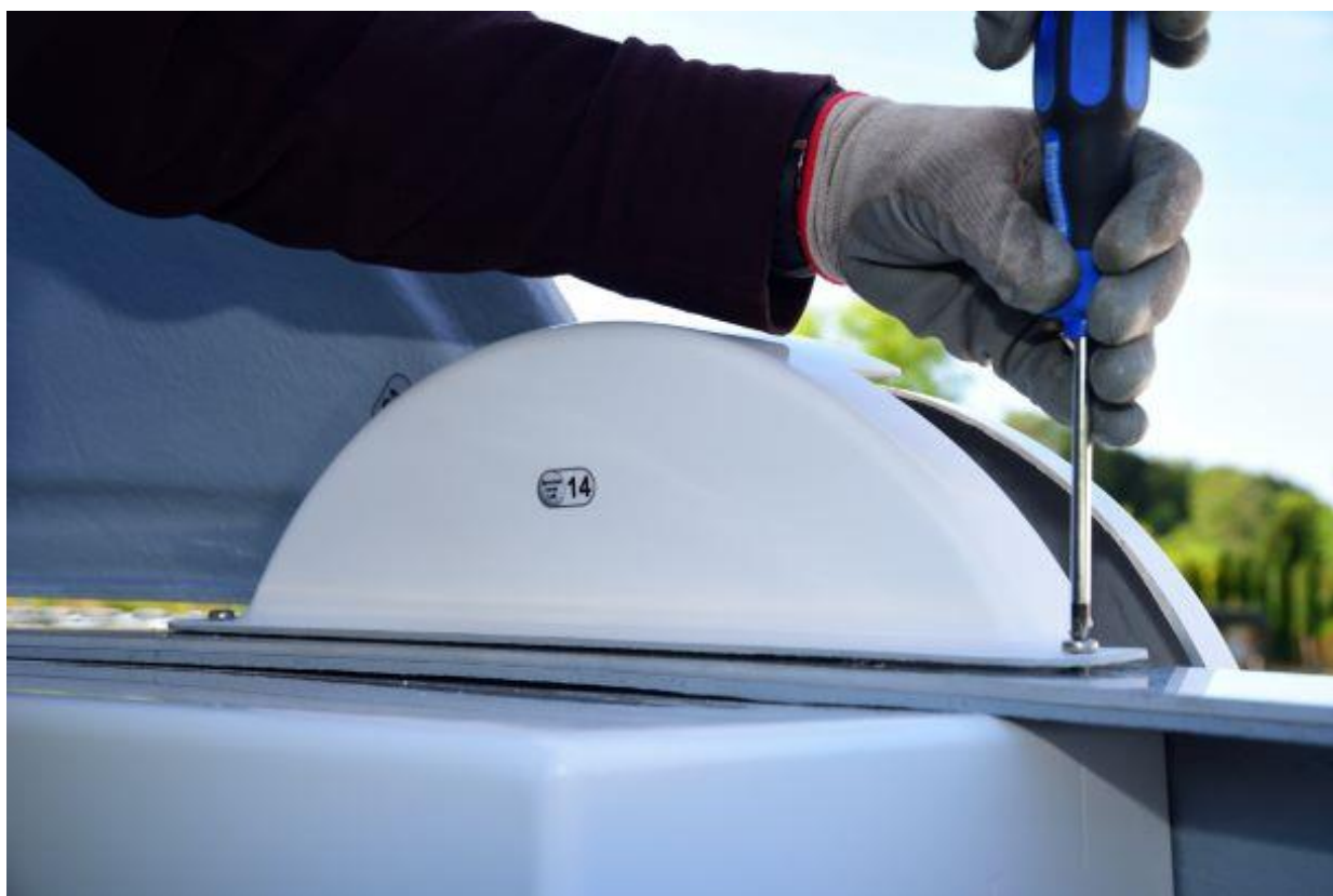
Rys. 58 – instalacja osłony wewnętrznej zębatek
