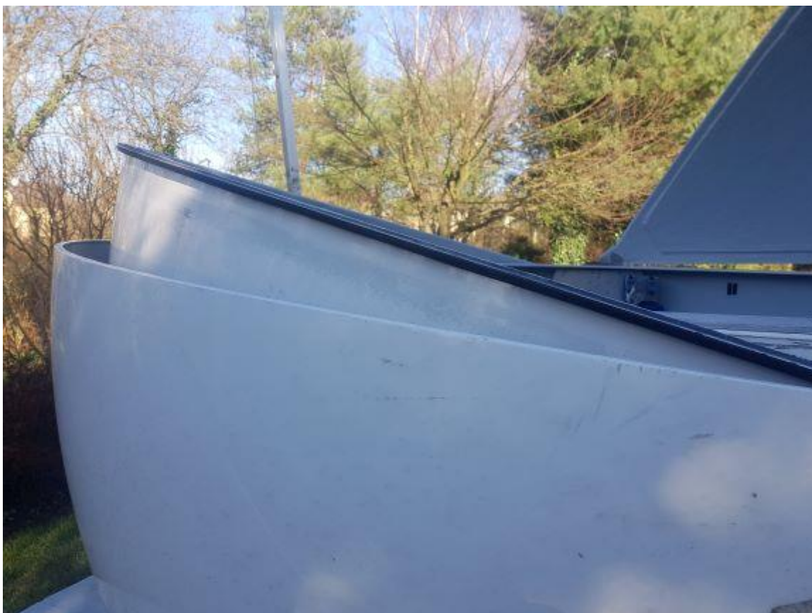
Rys. 66 – Otwarcie pokrywy nr2 do instalacji uszczelki
