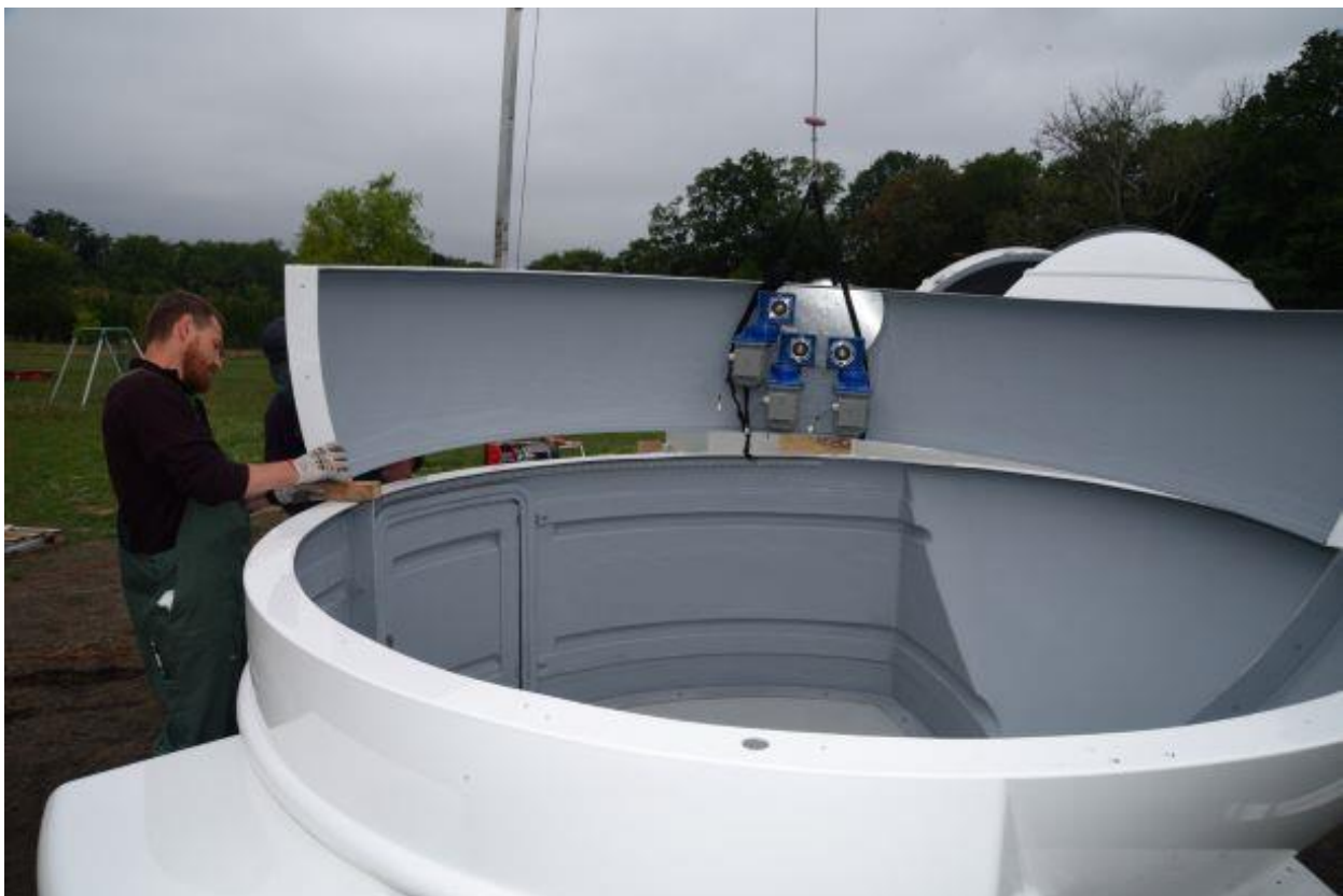
Rys. 19 – przygotowanie do montażu górnej części podstawy kopuły
