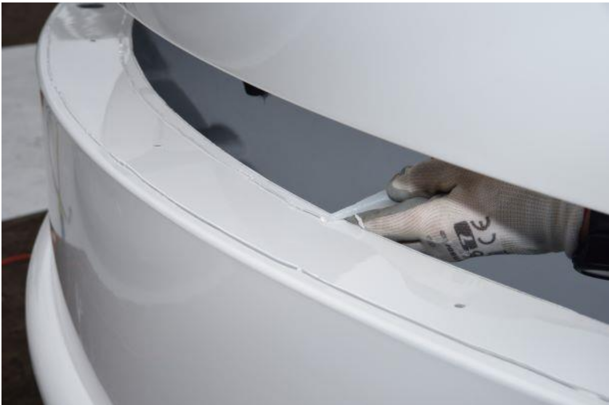
Rys. 21 – uszczelnianie miejsc łączenia elementów podstawy kopuły c.d.
