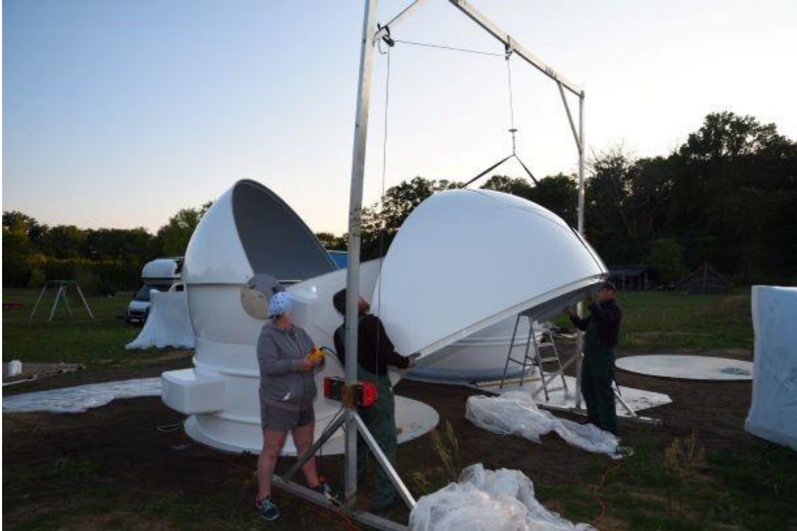
Rys. 51 - pokrywa nr 3 przed montażem
