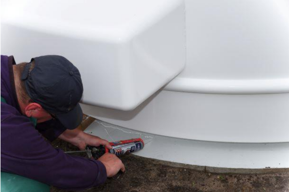
Rys. 14 – nakładanie uszczelnień pod podstawą kopuły
