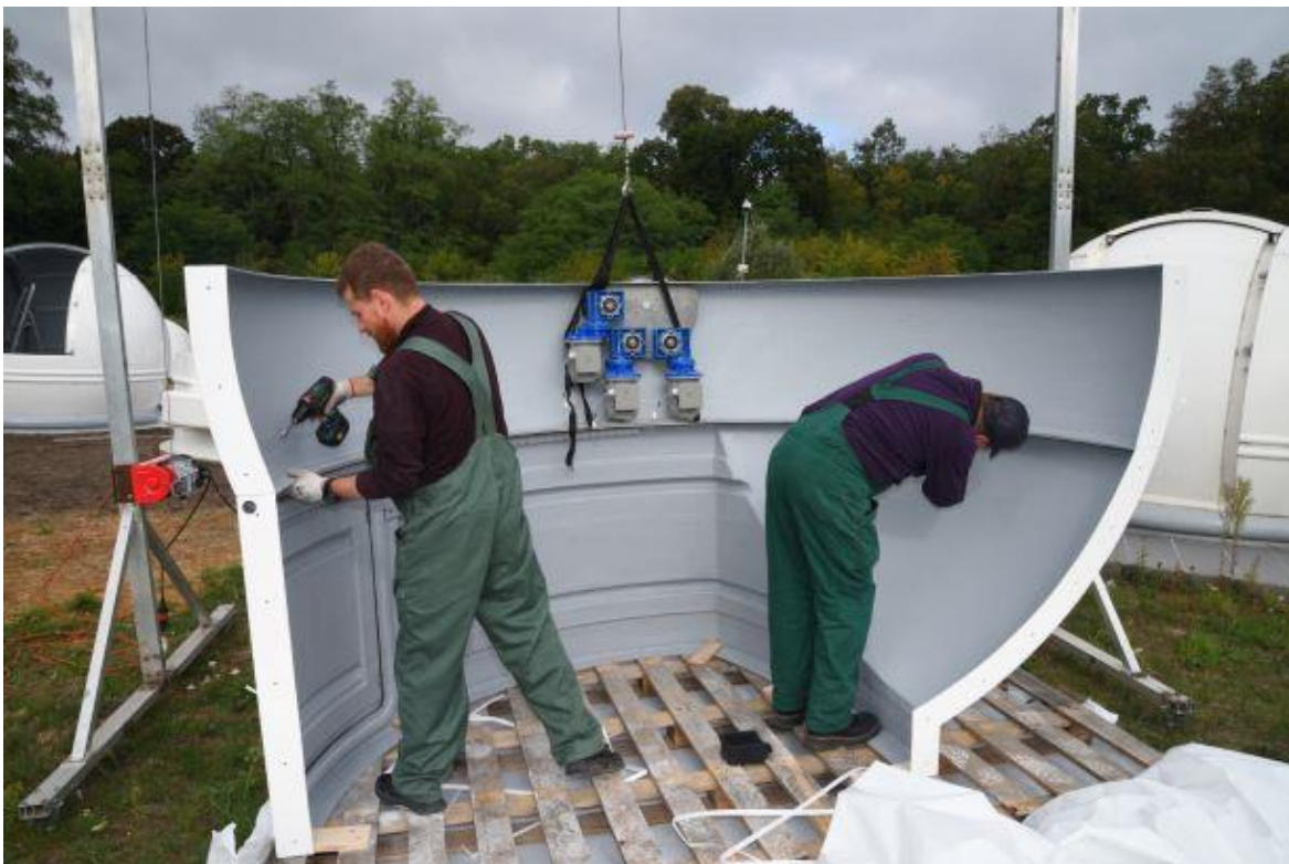
Rys. 7 – demontaż śrub M6 łączących górną i dolną część podstawy kopuły do przeniesienia na miejsce instalacji
