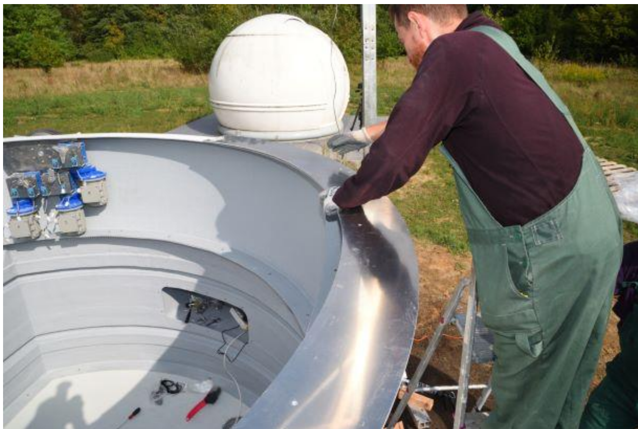
Rys. 29 – Zabezpieczanie pierścienia w miejscu instalacji za pomocą śrub montażowych
