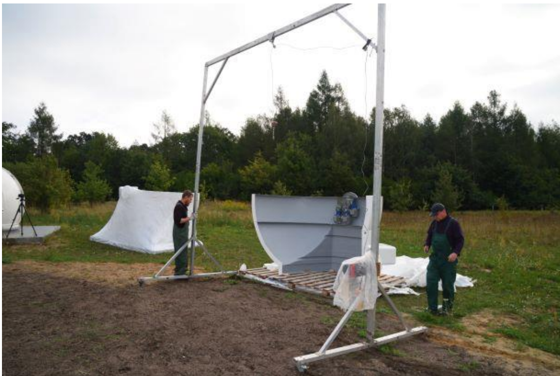
Rys. 4 – bramownica z napędem elektrycznym wykorzystana do montażu kopuły
