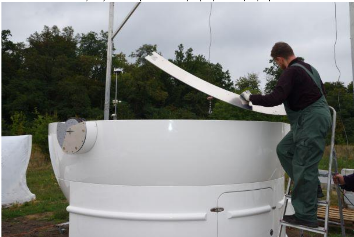
Rys. 26 – Sposób orientacji szerszej części pierścienia na podstawie kopuły
