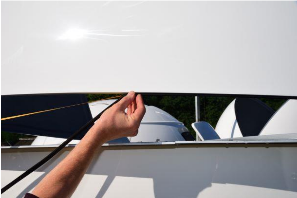
Rys. 64 – Montaż uszczelki na krawędzi pokrywy nr 1.
