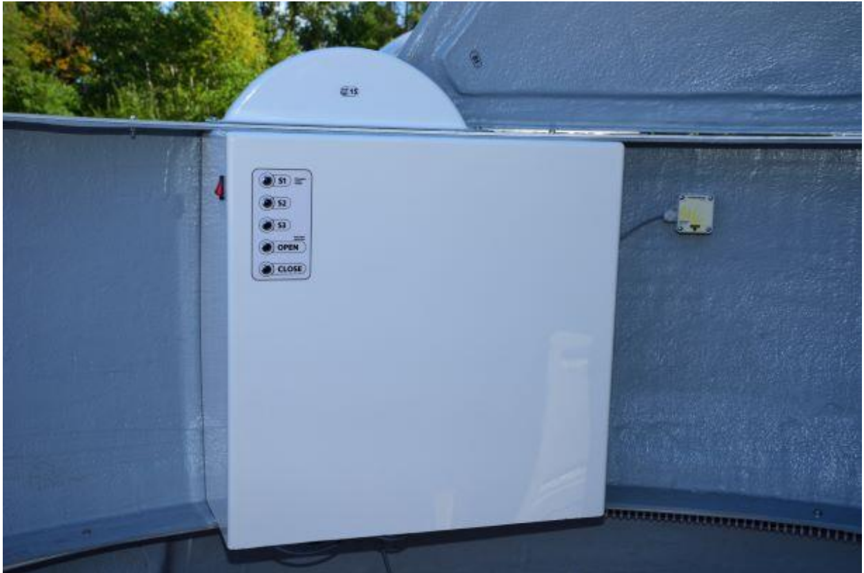
Rys. 58 – Zamontowana osłona wewnętrzna zespołów napędowych.
