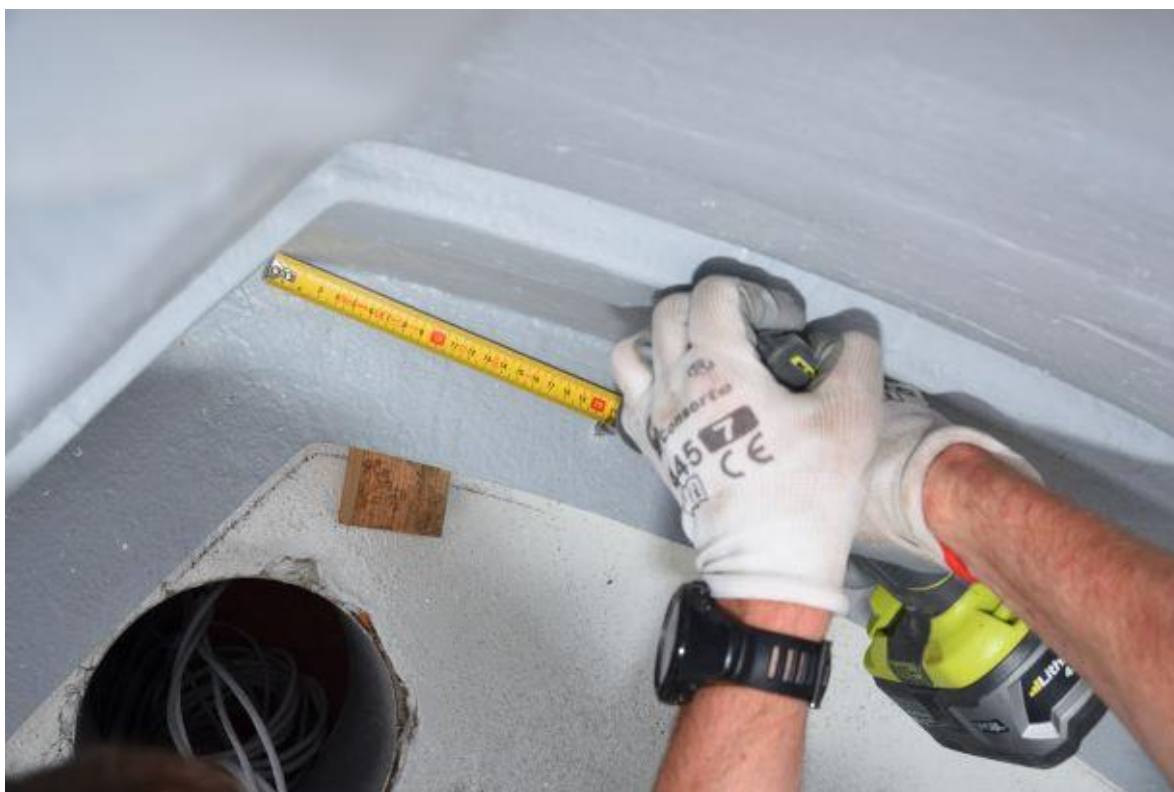
Rys. 12 – wiercenie otworów mocujących podstawę
