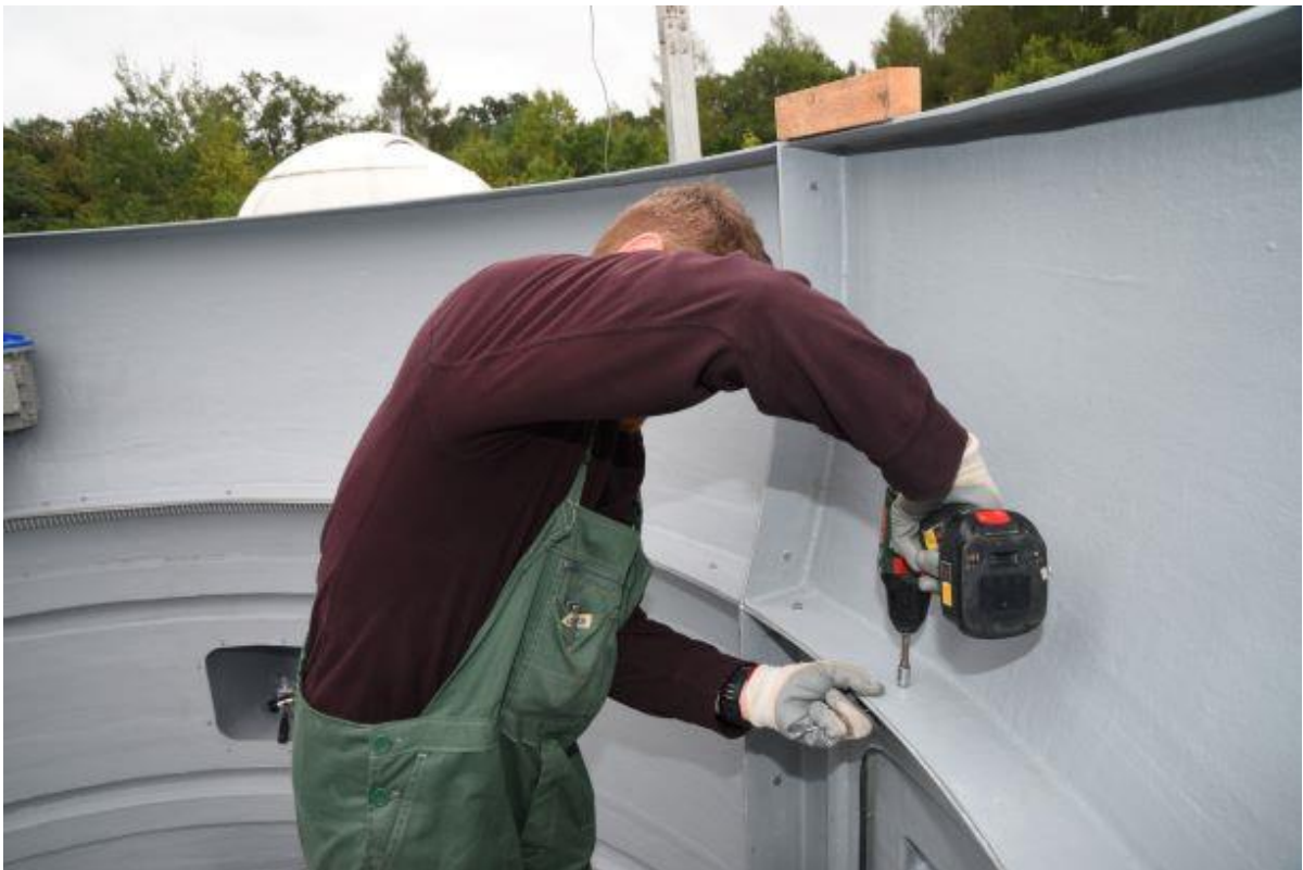
Rys. 25 – Końcowe skręcanie śrubami górnych elementów podstawy kopuły
