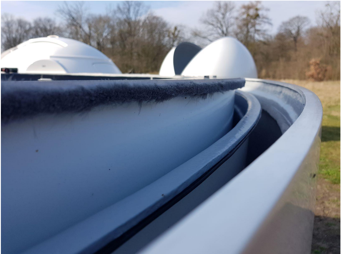
Rys. 71 –Sposób instalacji uszczelki pod pierścieniem uszczelniającym
